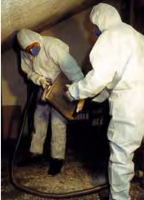
Foto 12: Arbeiten in einem massiv kontaminierten Bereich.
